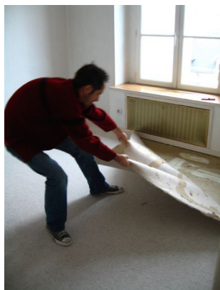
Figure 1: Arrachage d'une moquette par pelage.
