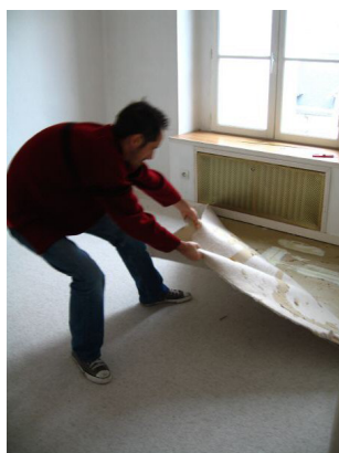
Figure 1: Arrachage d'une moquette par pelage.
